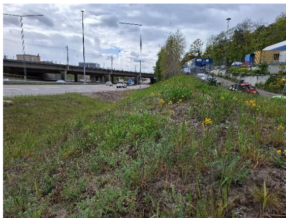
Figur 23. Örtrik del av vägrenen.
